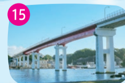
Jogashima Ohashi Bridge
